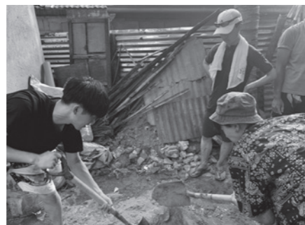
コンクリートを作る作業
