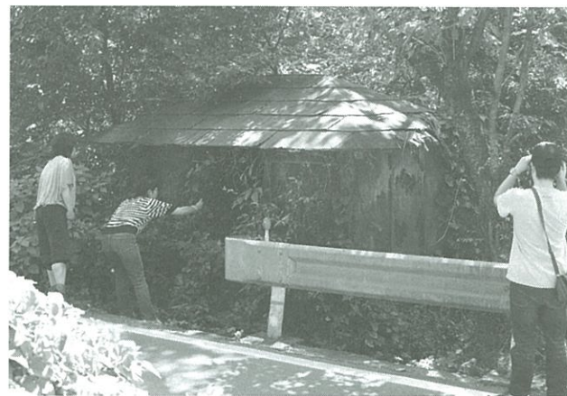
現存する椀倉の調査
