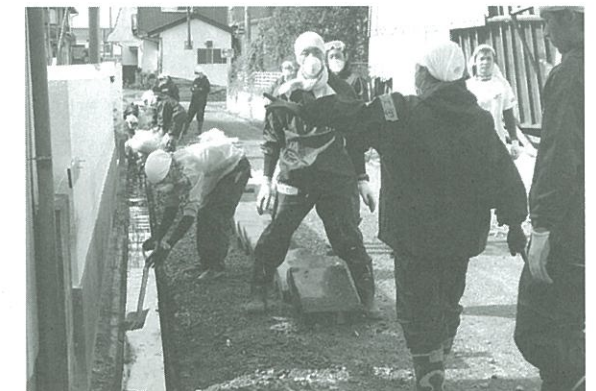
側溝のヘドロ除去作業 感染症などを防ぐために早急な除去が必要
